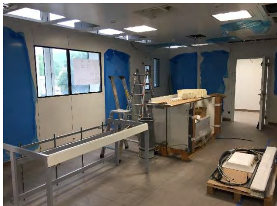
Blick in den neuen Reinraum (letzte Bauphase)
